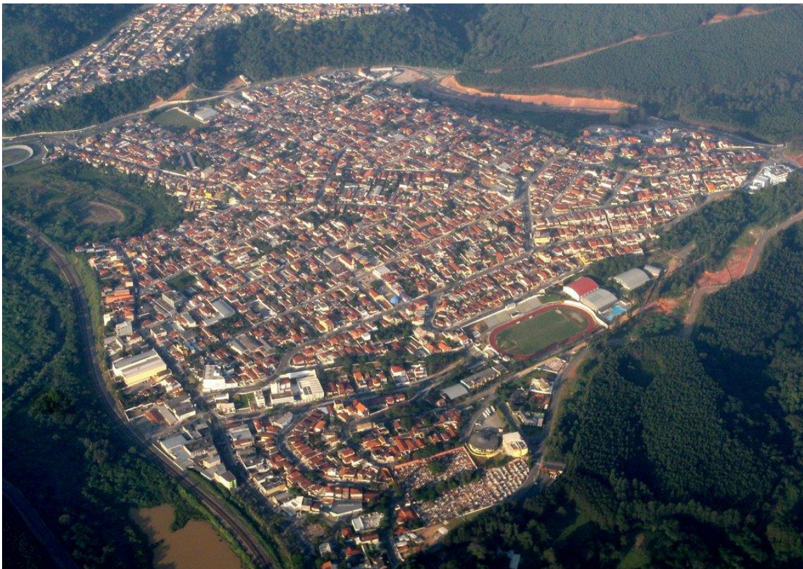
Figura 2. Vista aérea da cidade de Caieiras
