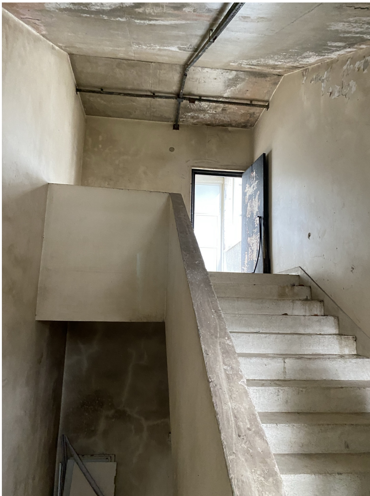
Figura 26 – ESCADA EXISTENTE DA EDIFICAÇÃO 27
