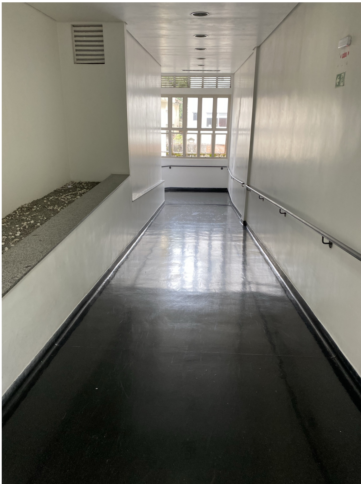
Figura 24 – RAMPA INTERNA DA EDIFICAÇÃO 26
