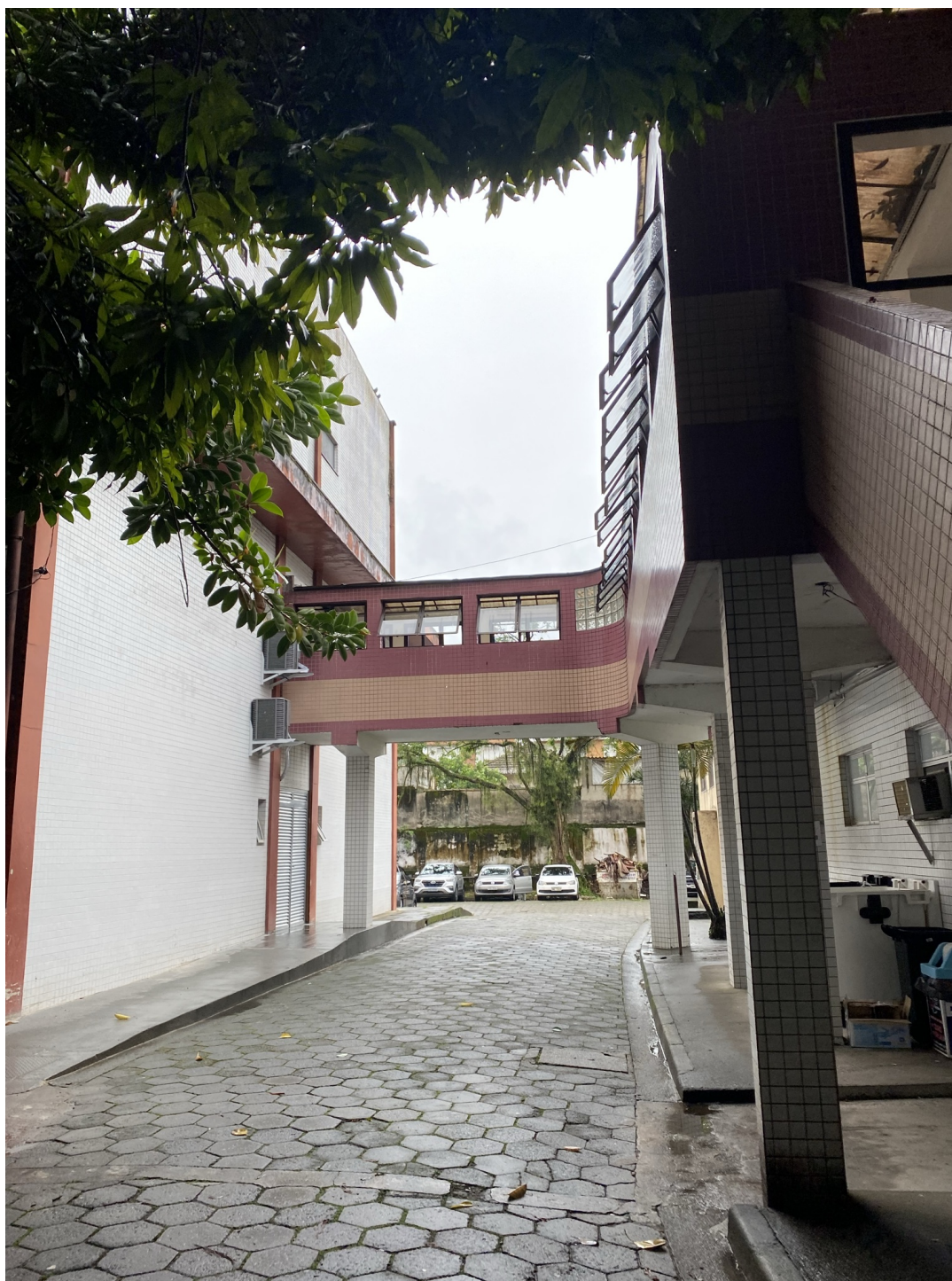
Figura 22 – PASSARELA DE INTERLIGAÇÃO ENTRE EDIFICAÇÃO 24 E 26
