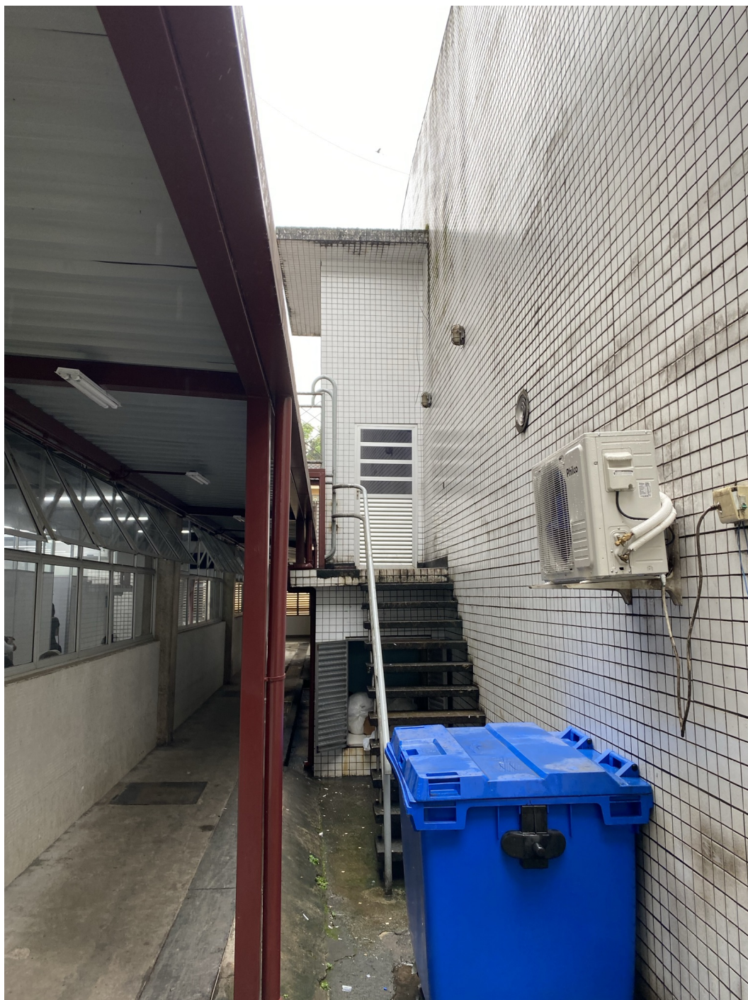
Figura 25 – ESCADA EXISTENTE DA EDIFICAÇÃO 26, AO LADO DA EDIFICAÇÃO 27
