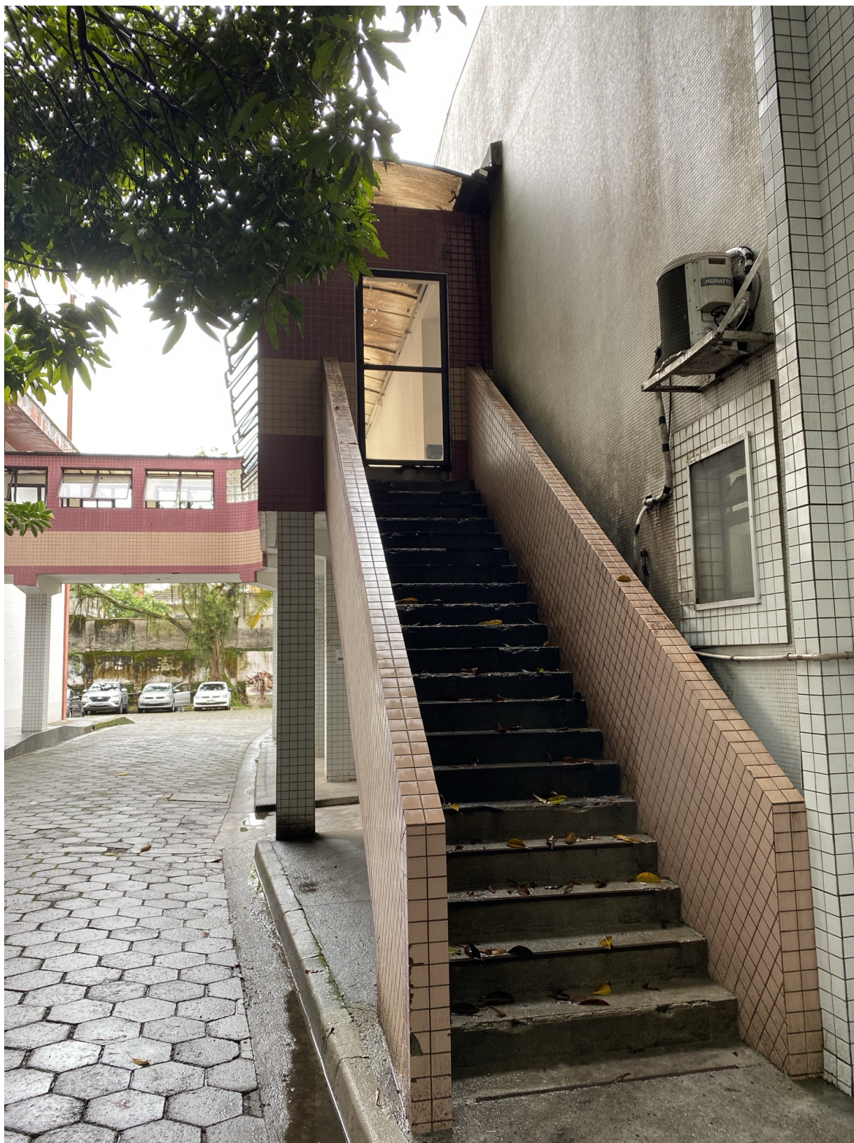
Figura 23 – ESCADA EXISTENTE DE ACESSO A PASSARELA
