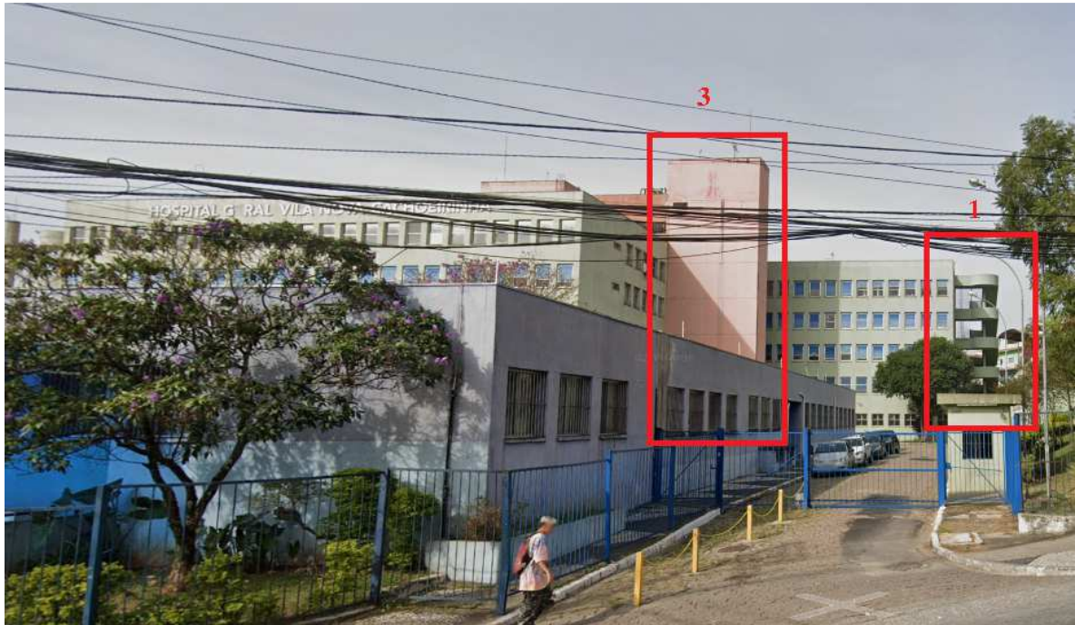
Figura 4 – IMAGEM ESCADA 1/3 Á DEMOLIR E RECONSTRUIR
