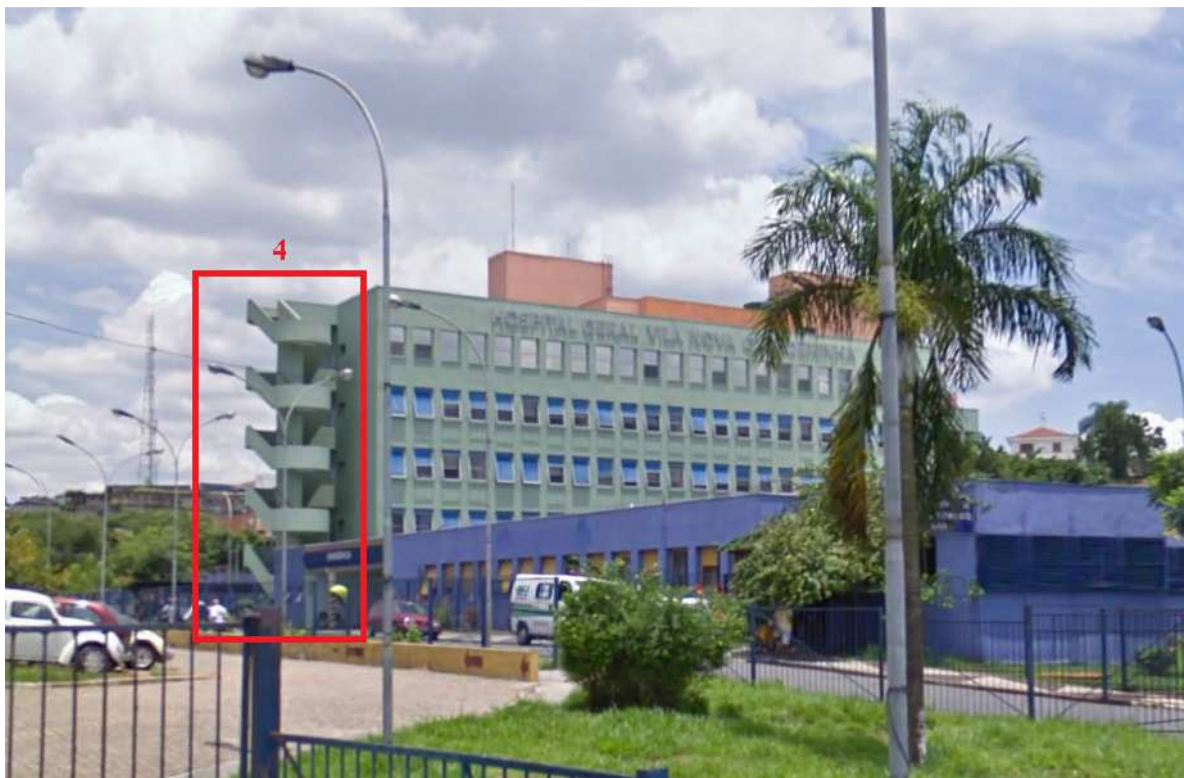
Figura 5 – IMAGEM ESCADA 4 Á DEMOLIR E RECONSTRUIR
