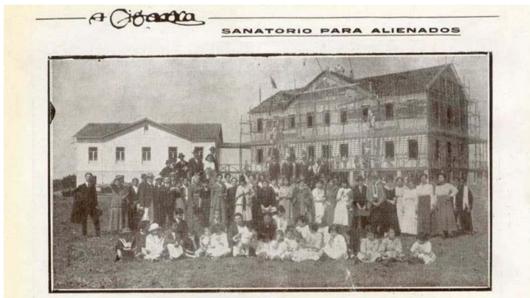
Figura 27 - Sanatório São Pedro e São Paulo em construção em 1918
