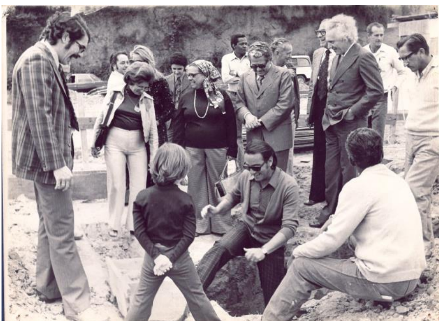
Figura 21 – Posto Macedo – Pedra Fundamental e Caixa Fundamental II
