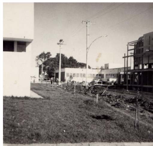
Instituto de Cardiologia em obras (Hospital - 1)
