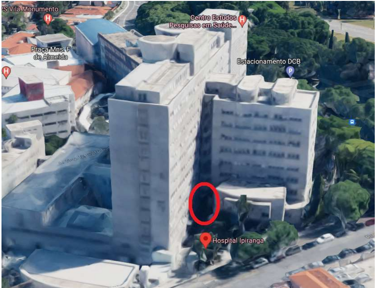
Figura 54 – ESCADA METÁLICA – IMPLANTAÇÃO – Fonte imagem google maps
