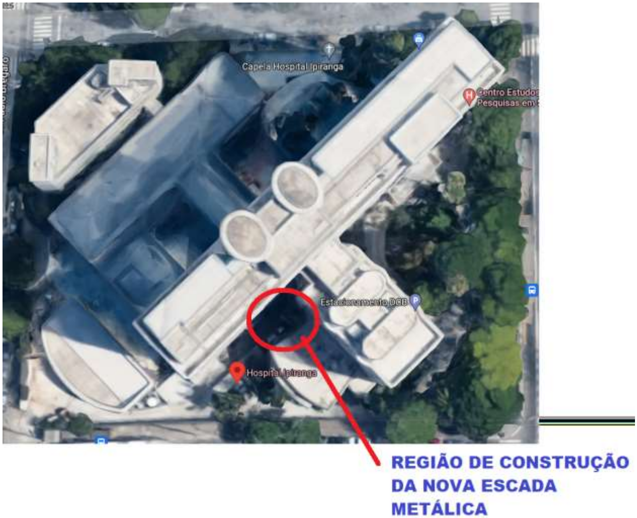
Figura 53 – ESCADA METÁLICA – IMPLANTAÇÃO – Fonte imagem google maps
