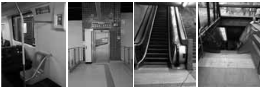
Adequação das instalações – assento preferencial nos trens, elevadores, sinalização das escadas rolantes e escadas fixas.
